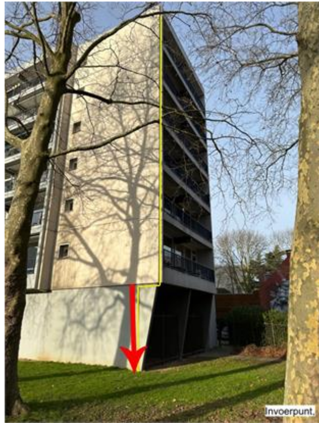
Locatie opvoerpunt 6, hier komen 6 kabels te liggen voor de nummers 2, 4, 6, 146, 148 en 150
