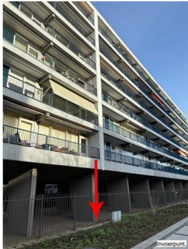
Locatie opvoerpunt 4, hier komen 48 kabels te liggen voor de nummers 38-84 en 182-228
