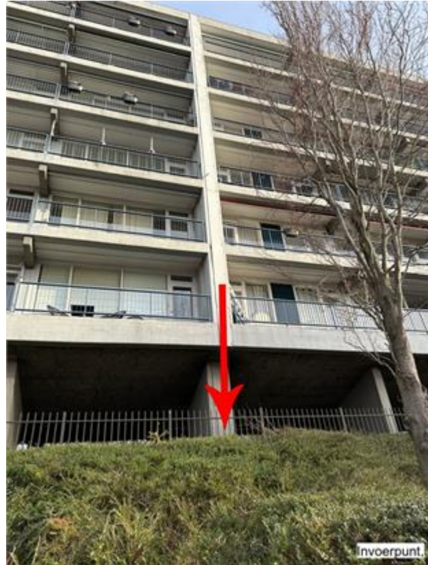
Locatie opvoerpunt 2, hier komen 48 kabels te liggen voor de nummers 92-138 en 236-282
