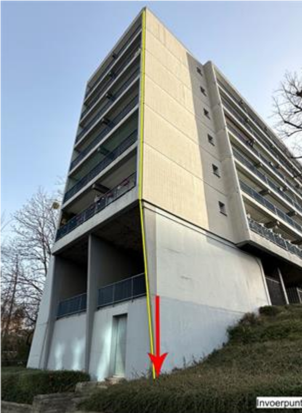
Locatie opvoerpunt 1, hier komen 6 kabels te liggen voor de nummers 86, 88, 90, 230, 232 en 234
