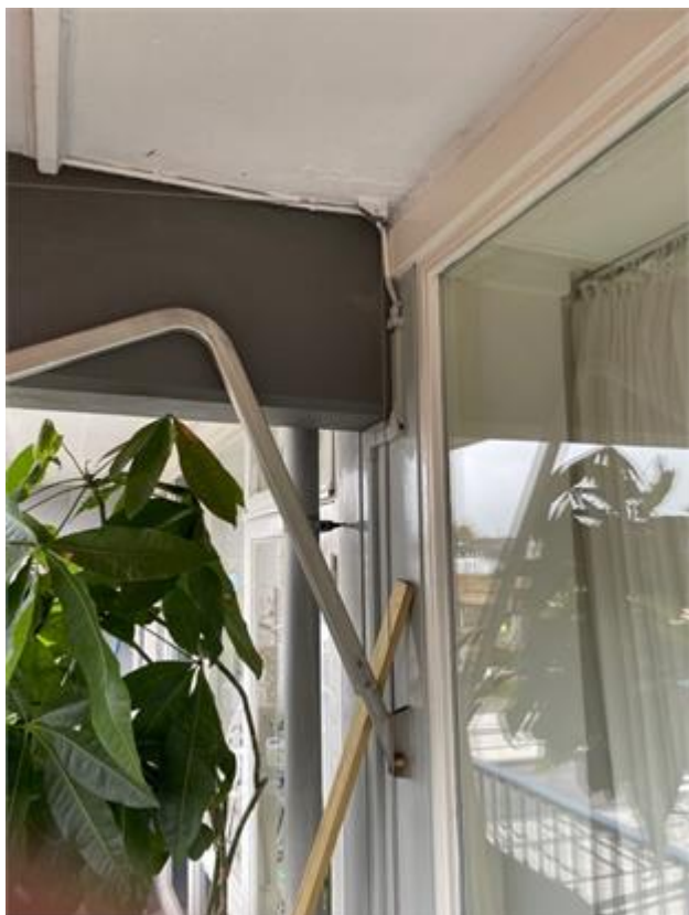
Vanuit de goot gaat de kabel naar beneden
