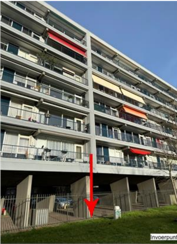
Opvoerpunt 5, hier komen 30 kabels te liggen voor de nummers 8-36 en 152-180
